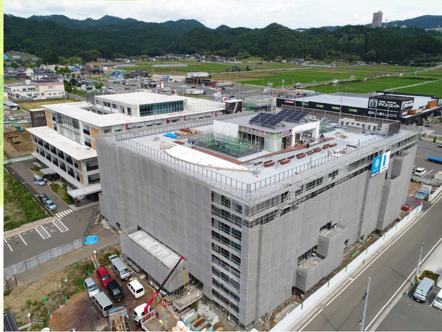
【外部進捗状況】
