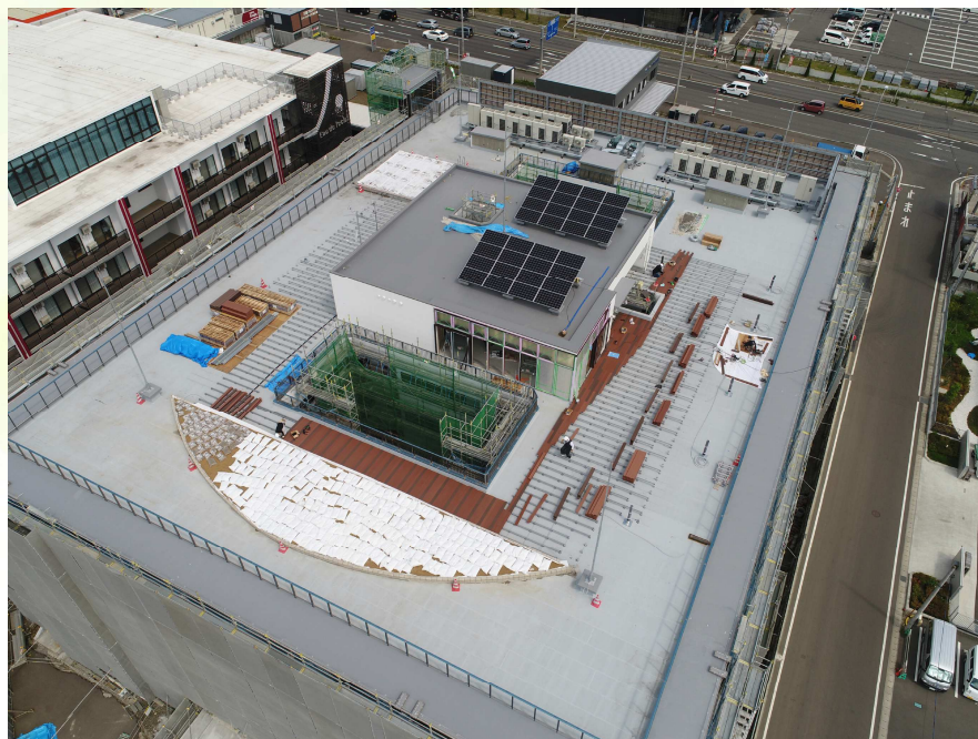
【屋上進捗状況】
