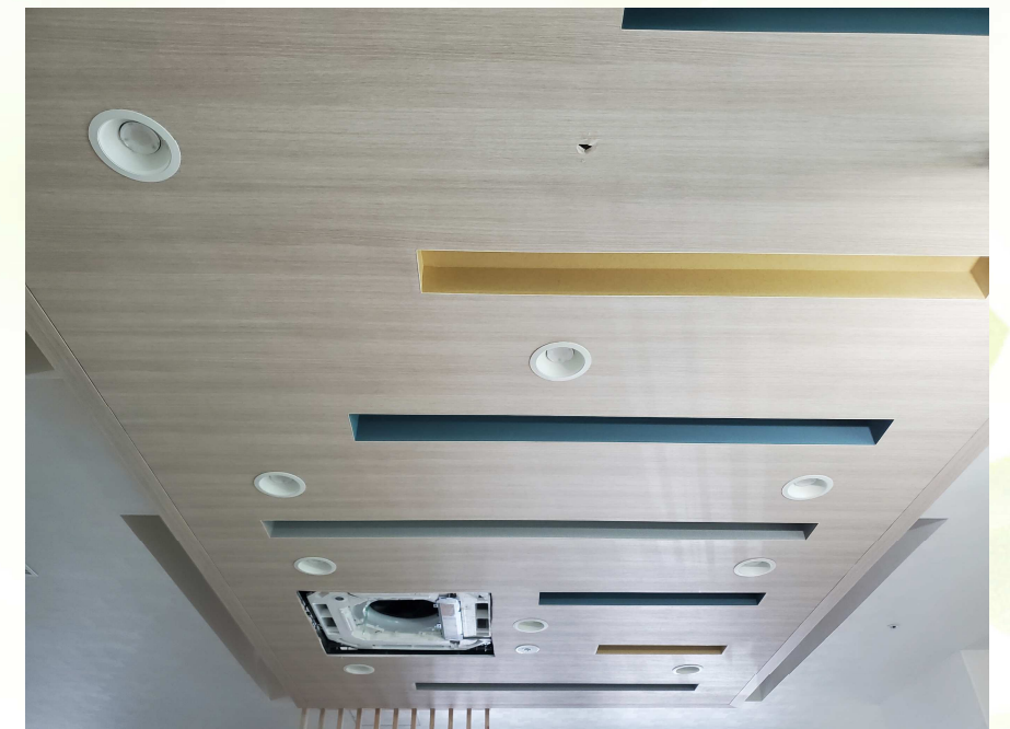
【共同生活室進捗状況（3階とちのき）】
