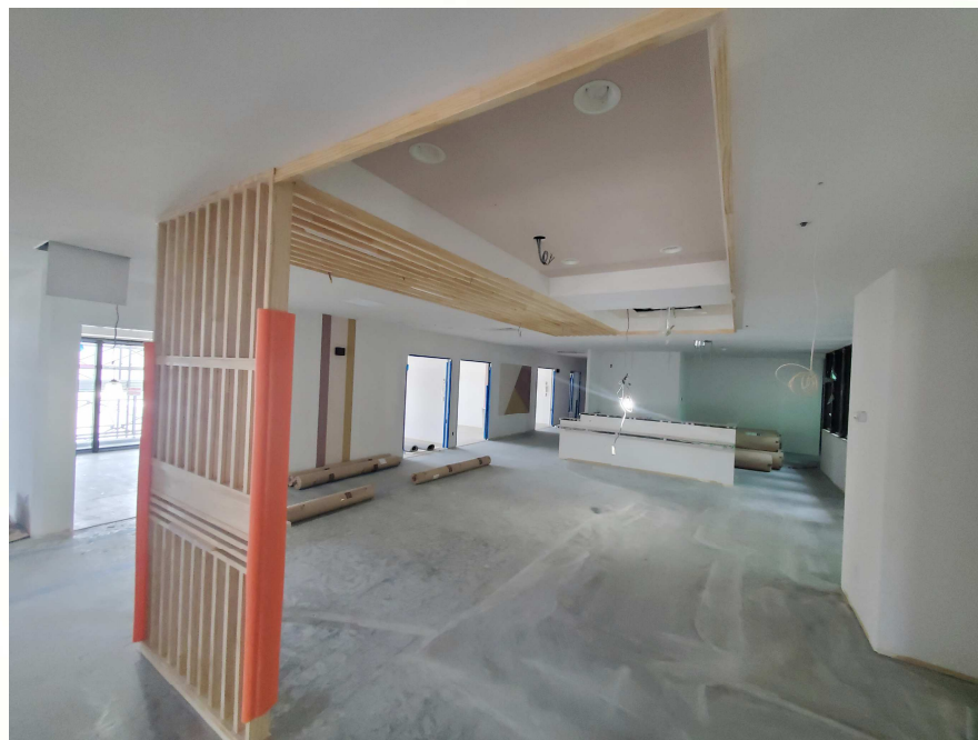
【共同生活室進捗状況（2階さくら）】
