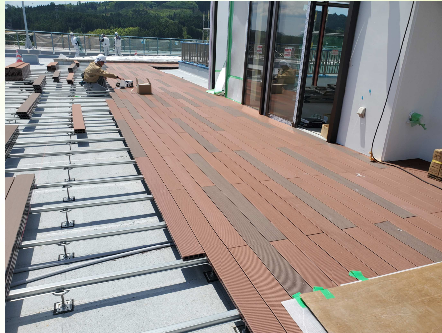
【ウッドデッキ敷設状況】
