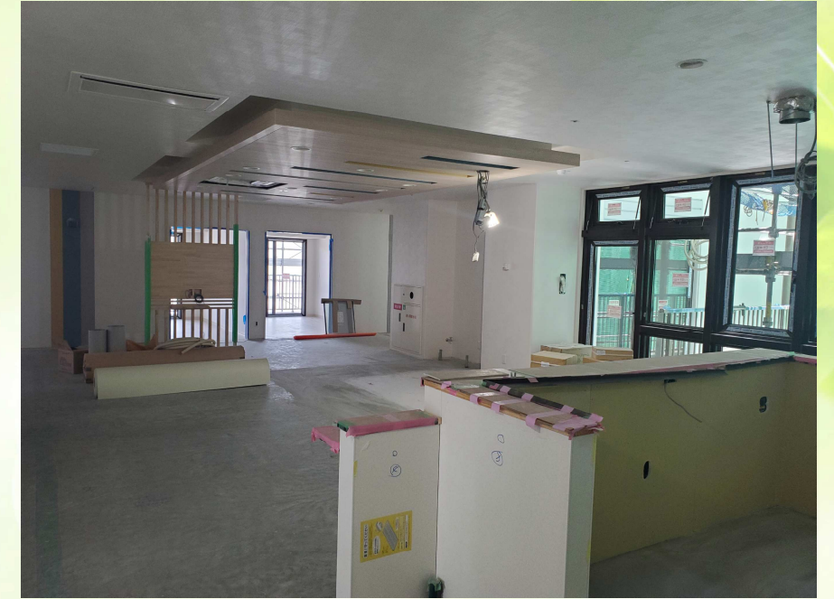
【共同生活室進捗状況（3階とちのき）】
